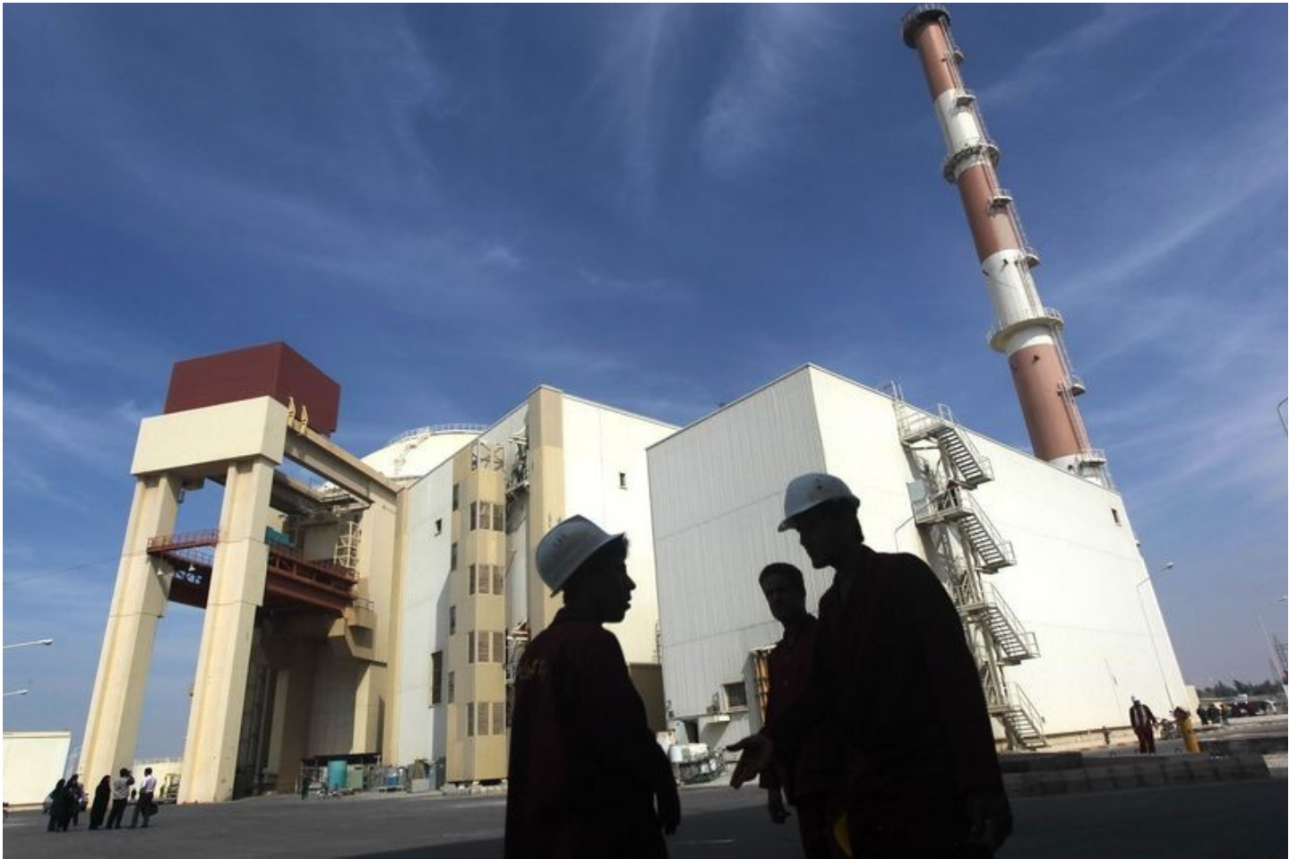
Le bâtiment du réacteur de la centrale nucléaire de Bushehr, dans le sud de l'Iran (Majid Asgaripour/AFP/Getty Images)
