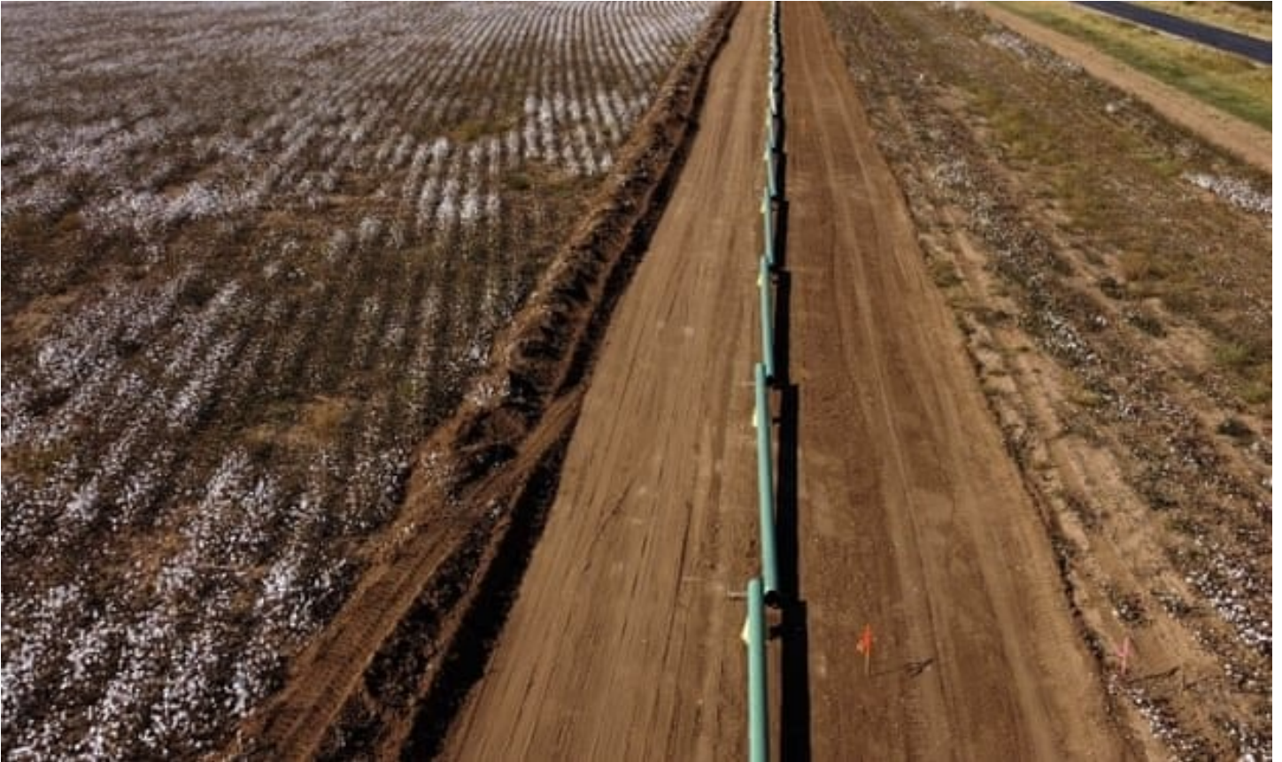
Des tuyaux sont posés dans un champ de coton en attendant d'être installés pour de nouveaux oléoducs à Lenorah, au Texas (David Goldman/AP)
