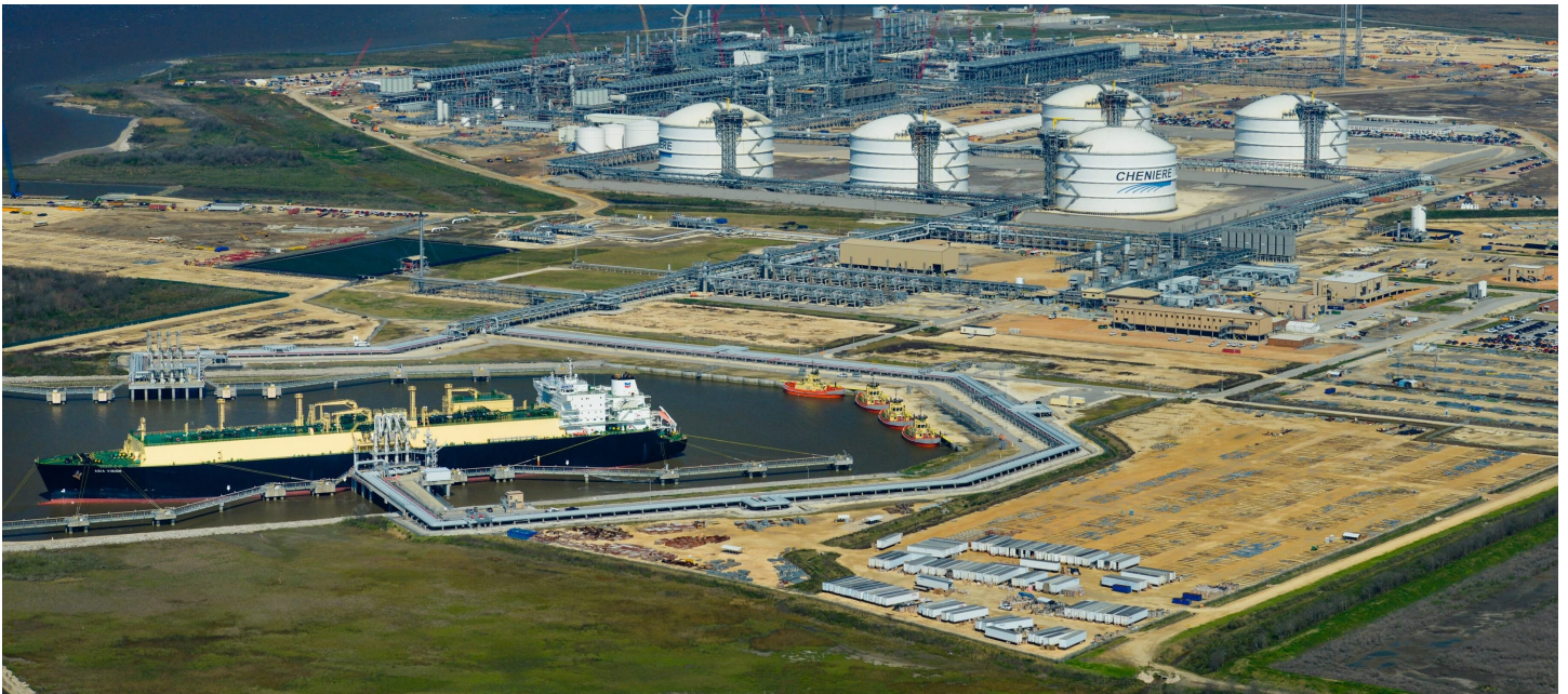
L'usine de liquéfaction et le terminal de gaz naturel liquéfié (GNL) de Sabine Pass (Louisiane) appartenant à la firme texane Cheniere Energy (Jeffrey Ball - Canary Media)
