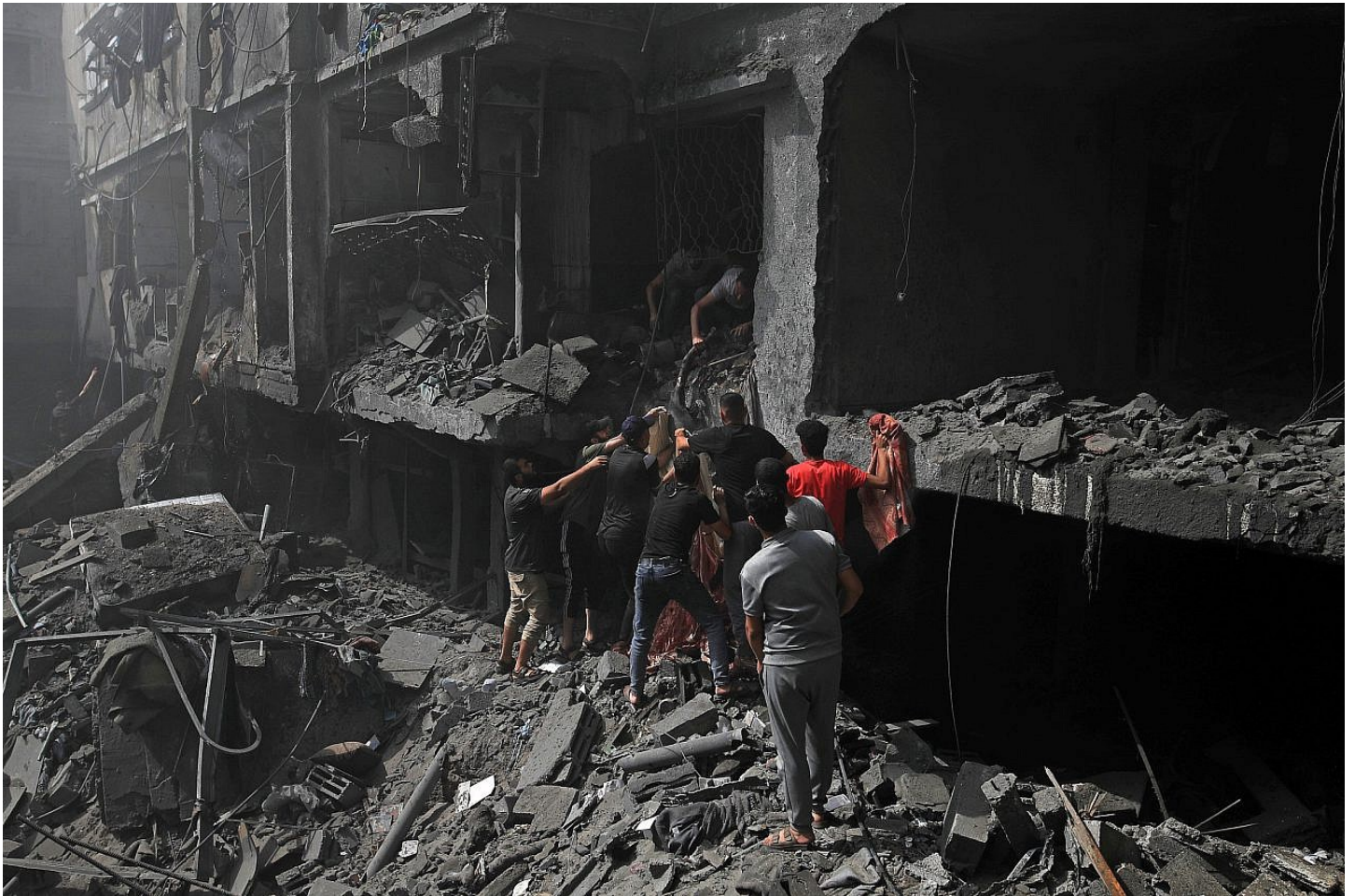
Des Palestiniens tentent de sauver des survivants et de retirer des corps des décombres après que des frappes aériennes israéliennes ont touché des bâtiments près de l'hôpital Al-Aqsa Martyrs à Deir al-Balah, au centre de Gaza, le 22 octobre 2023. (Mohammed Zaanoun/Activestills)
