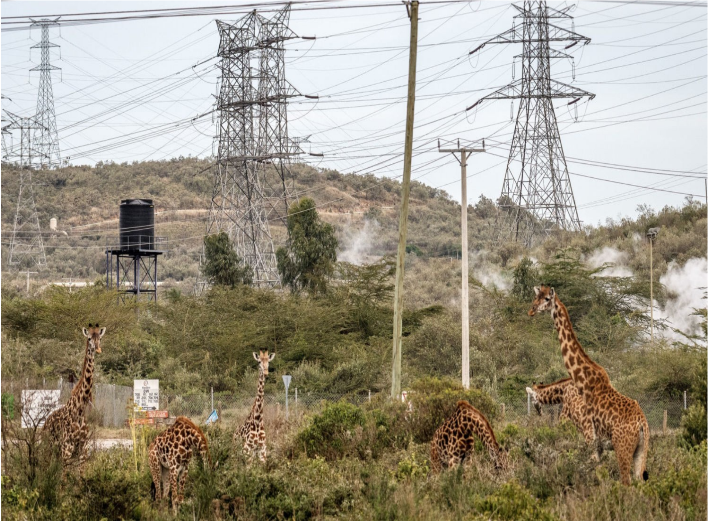
Des girafes massais côtoient les infrastructures géothermiques dans le parc national de Hell's Gate, au Kenya. ADAM WELZ
