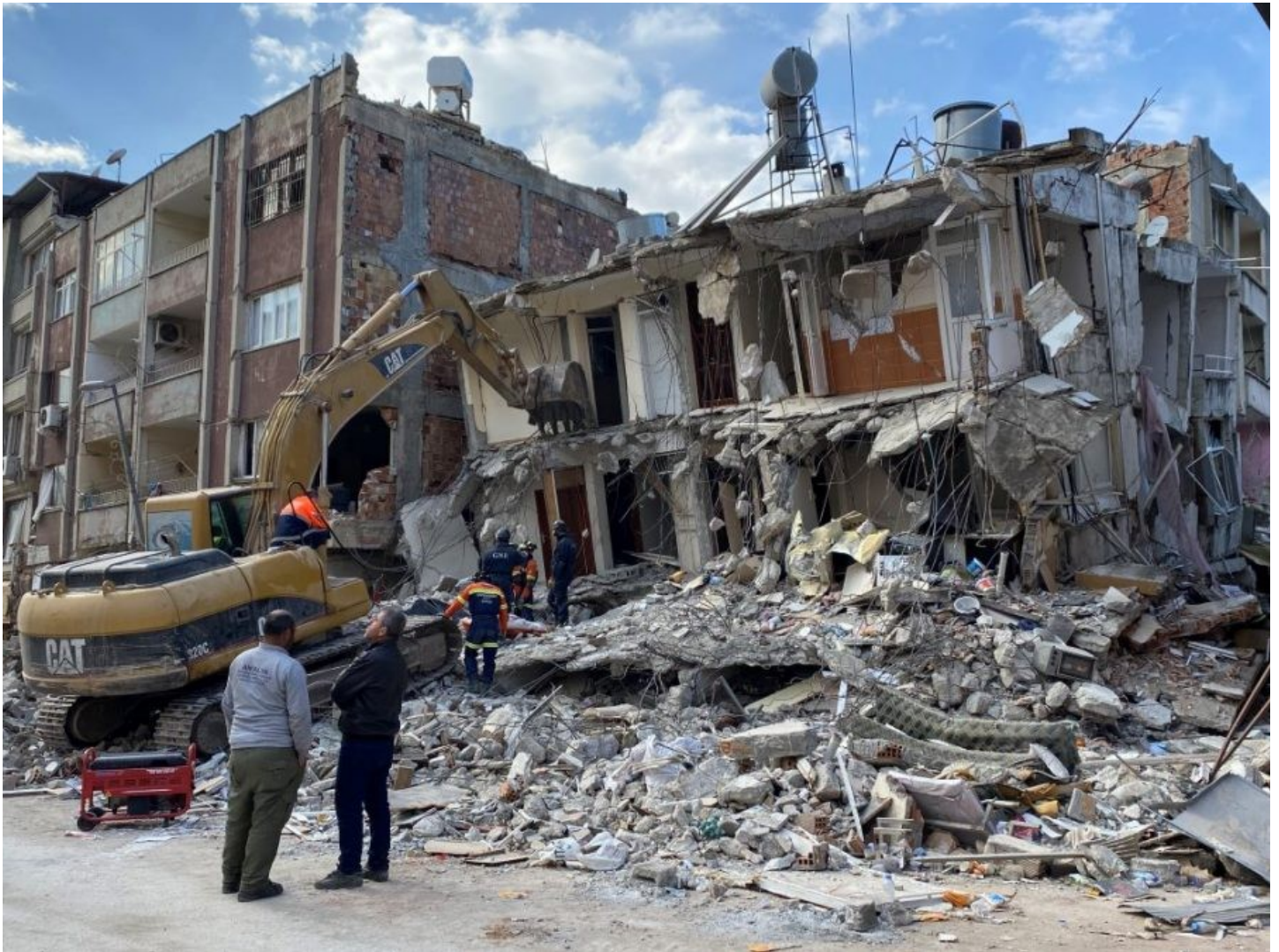
Déblaiement des constructions détruites (İzel Sezer / İleri Haber)
